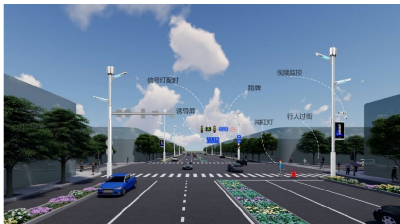
图 17 基于多功能智慧杆的车路协同设施
